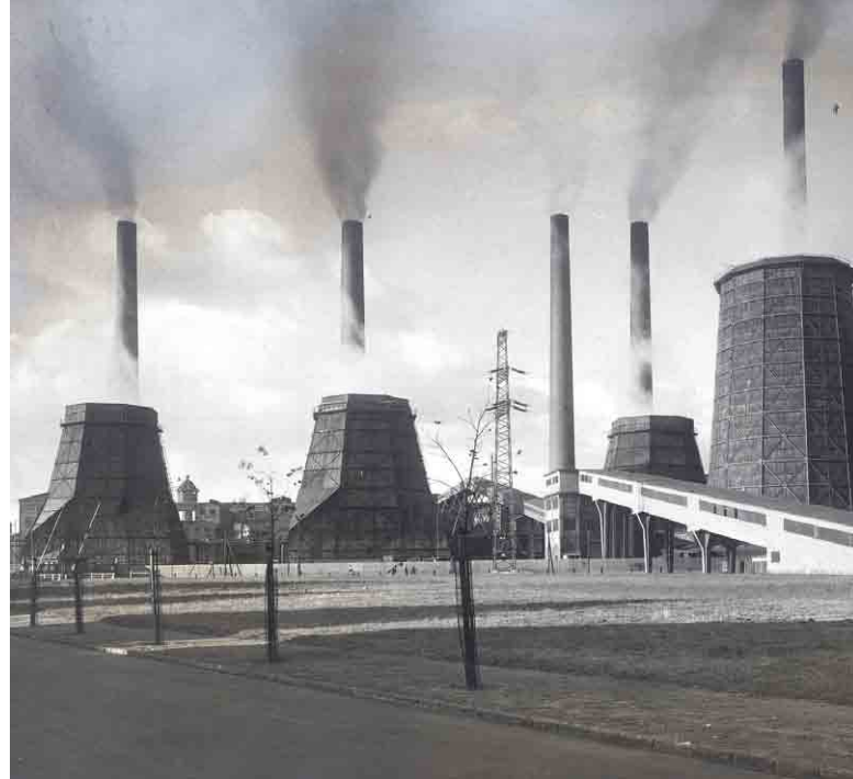
Kraftwerk Süd mit Blick auf die Kühltürme und Schornsteine der Industrie- bzw. Kraftanlage, undatiert (Kreismuseum Bitterfeld, Fotothek, Nr. 01256)
