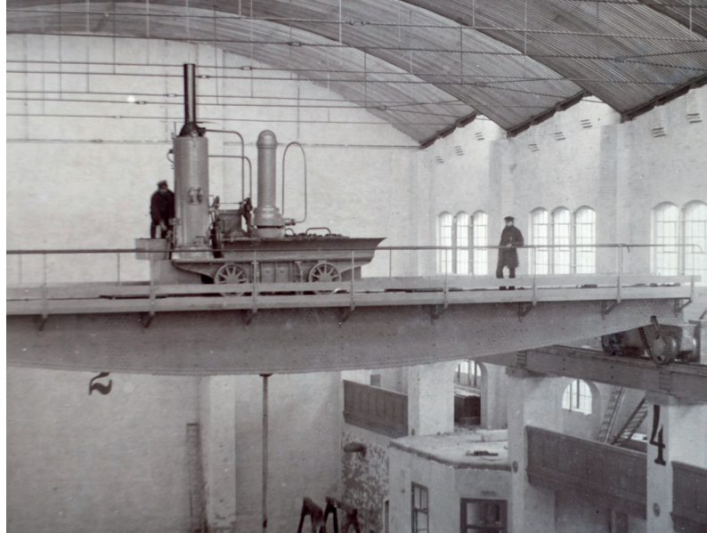
Dampfbetriebener Kran (LASA, I 28, Nr. Foto 21, Foto K 77)
