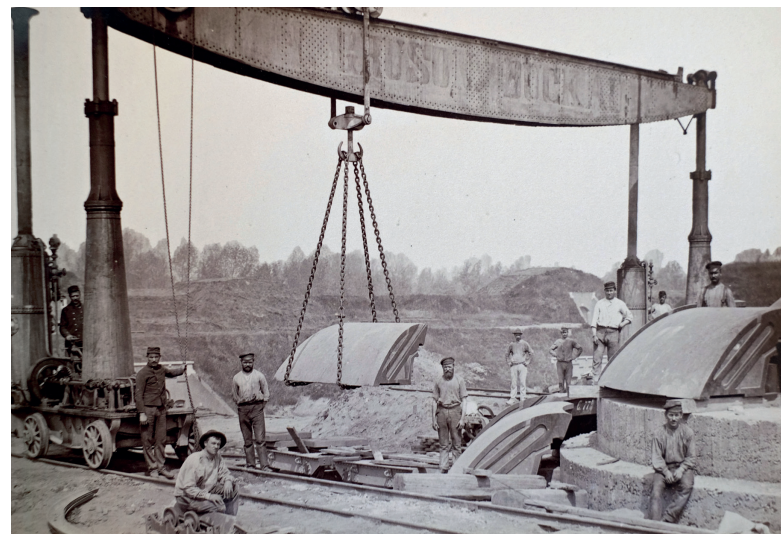
Montage Panzerturm (LASA, I 28, Nr. Foto 5, Foto C 67)
